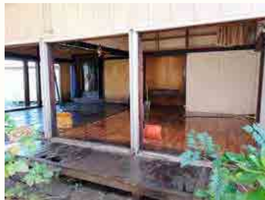
清掃作業後。溜まった汚泥を排出
