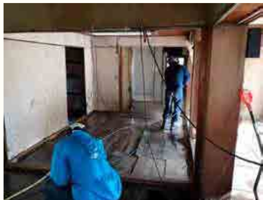
屋内の清掃作業
