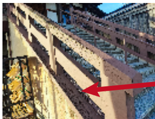
南東角・向拝の柱 塗装と補修工事
