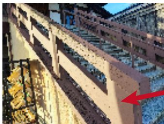
本堂手すりの塗装
